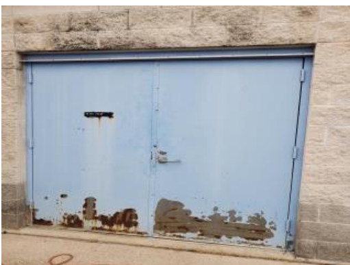
Exterior metal door
